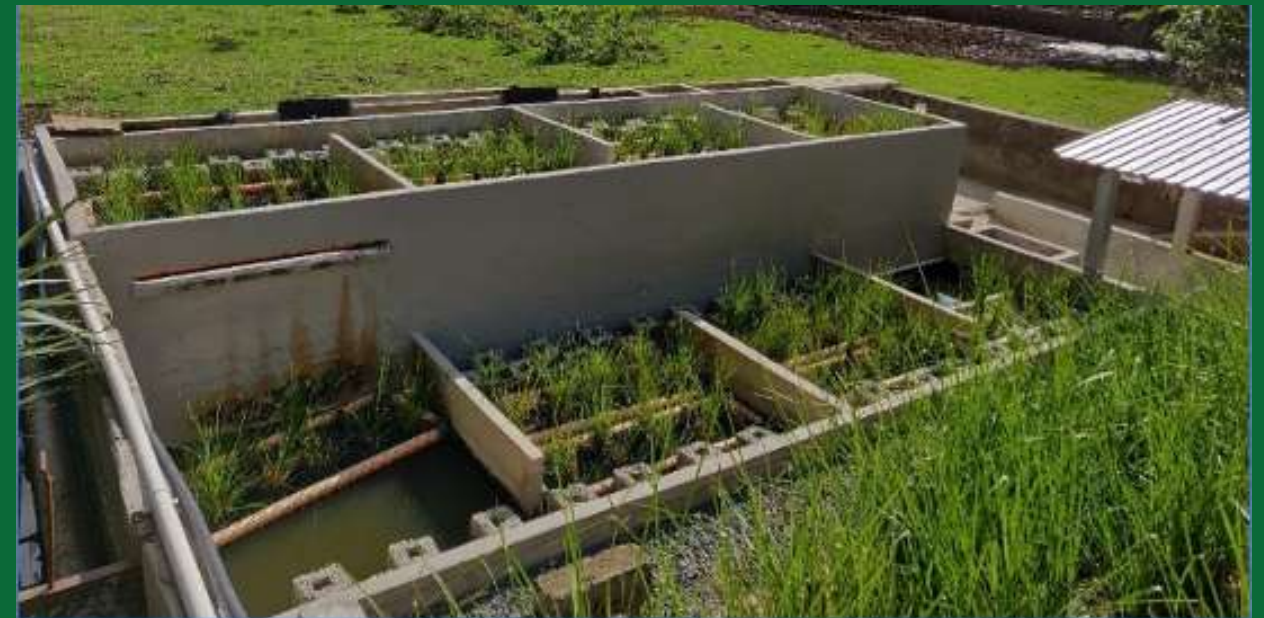
Primer prototipo de la Planta de Tratamiento con humedal de vetiver, construido en la Colonia Aurora II de la zona 13, Guatemala.
