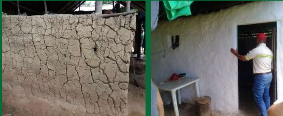
Antes y después de aplicar Ecorevoque en paredes de bahareque.
