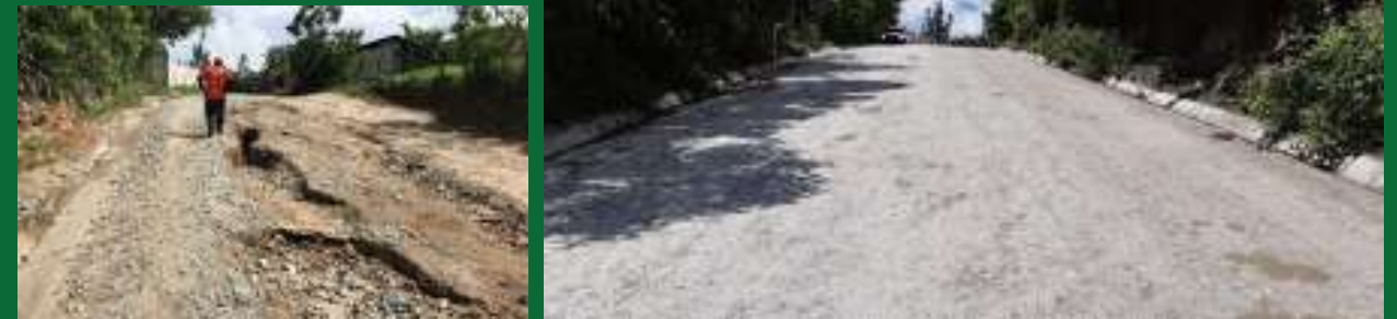
Antes y después de intervenir la RD-BV-11 con la técnica de Pavimento Unicapa de Alto Desempeño (Terraforte + material de aporte).
